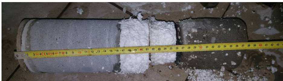
Fot. nr 5 – Odwiercony rdzeń
