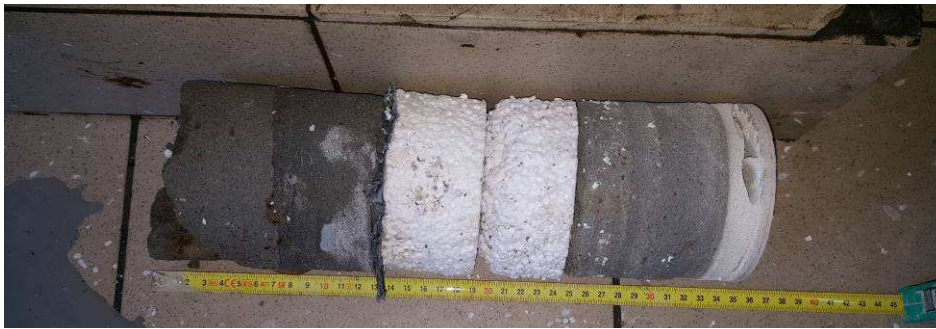
Fot. nr 7 – Odwiercony rdzeń
