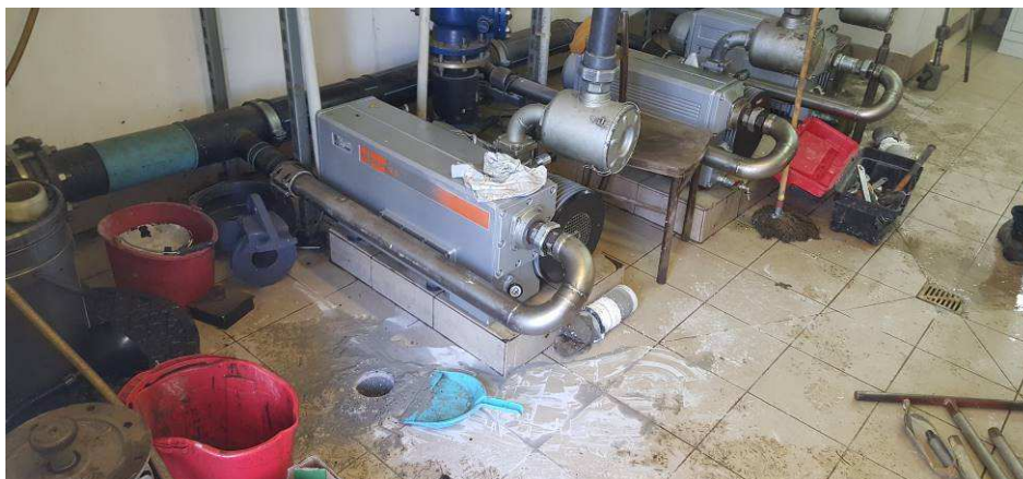
Fot. nr 6 – Miejsce odwiertu
