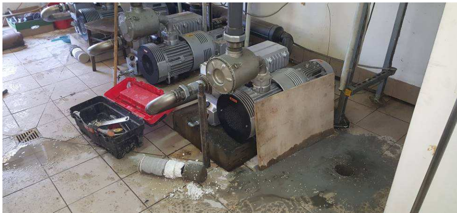
Fot. nr 4 – Miejsce odwiertu
